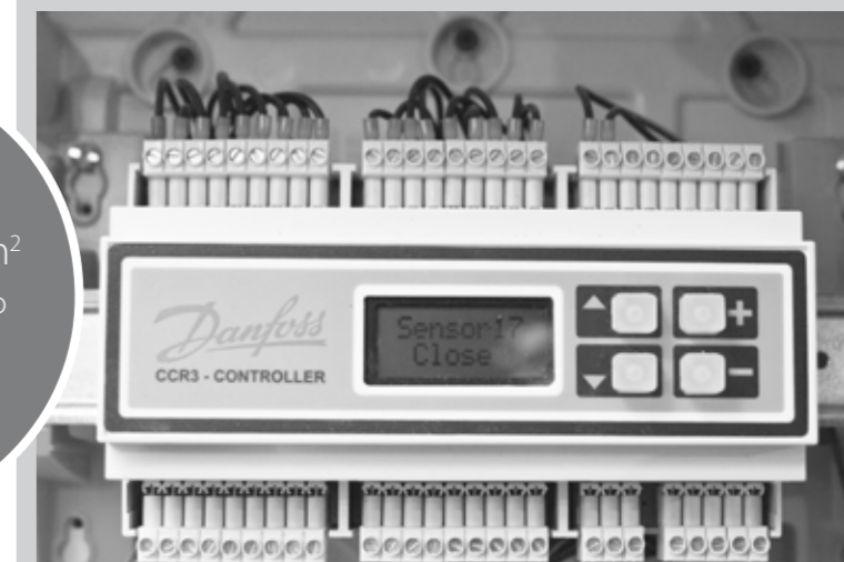
Keičiantis šilumos punkto temperatūroms, valdiklis automatiškai priderina grįžtamas stovų temperatūras.
