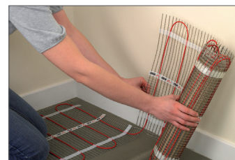
Après avoir vérifié l'état de surface (planéité, aspérité), dérouler la trame chauffante. Changement de direction du câble.
