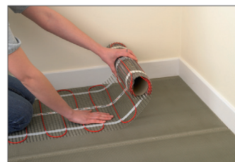
Après avoir vérifié l'état de surface (planéité, aspérité), dérouler la trame chauffante. Changement de direction du câble.
