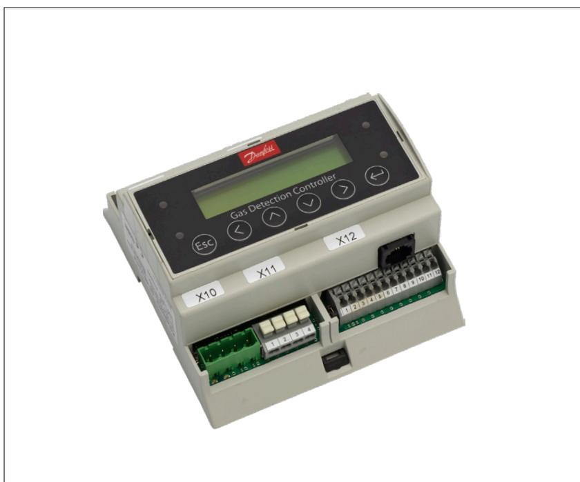
Der Gaswarnregler dient zur zentralen Überwachung von und Warnung vor gefährlichen Gaskonzentrationen. Die Eingangssignale für den Regler werden von den lokalen Gaswarngeräten des Typs Basic, Premium und Heavy Duty über eine RS485-Feldbus-Leitung oder eine analoge Verbindung gesammelt. Insgesamt können 96 Gaswarngeräte über Feldbus und 4 weitere über den analogen Anschluss direkt am Regler verwaltet werden (+28 weitere Geräte sind mit einem Erweiterungsmodul möglich).
