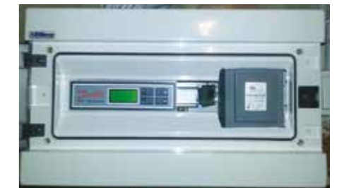
CCR3 grąžinamos temperatūros elektroninis reguliatorius
