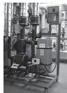
Sistemi posrednega ogrevanja z individualizirano postajo
