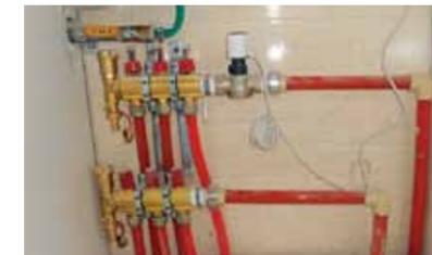
*Danfoss Verteiler mit RA-G-Ventil und TWA-A Stellantrieb. Diese Kombination wurde in den kleineren Wohnungen installiert, um eine zentrale Temperaturregelung über ein CWD-Thermostat im Wohnzimmer zu ermöglichen. In den größeren Wohnungen wurden individuelle Raumregler installiert.*
