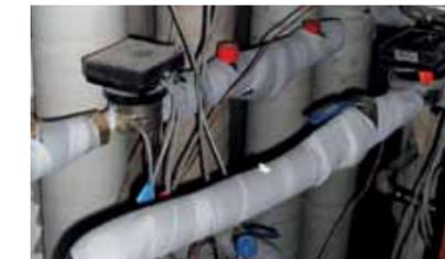
*Danfoss ASV-Abgleichventile und Energiemessgeräte wurden im Technikraum für jeweils vier Wohnungen installiert.*
