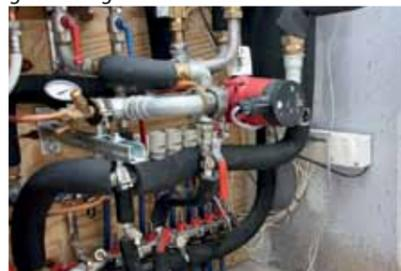
*Der Schaltschrank in den Wohnungen Heiz- und Kühlleitungen führen in die Wohnung und sind an den Verteiler angeschlossen. Durch einen manuellen Schalter können die Bewohner zwischen Heiz- und Kühlregelung wechseln. CF2 umfasst verschiedene Funktionen für eine optimale Regelung der Fußbodenkühlung und der CF-MC Hauptregler öffnet und schließt die elektrischen Stellantriebe automatisch. Jeder wird von einem der CF-R Raumthermostate aus geregelt.*
