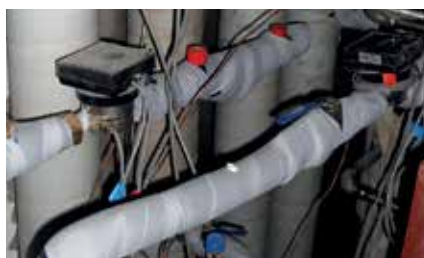
Kiekvienoje butų grupės techninėje patalpoje buvo sumontuoti Danfoss balansavimo vožtuvai ASV ir energijos matuokliai.
